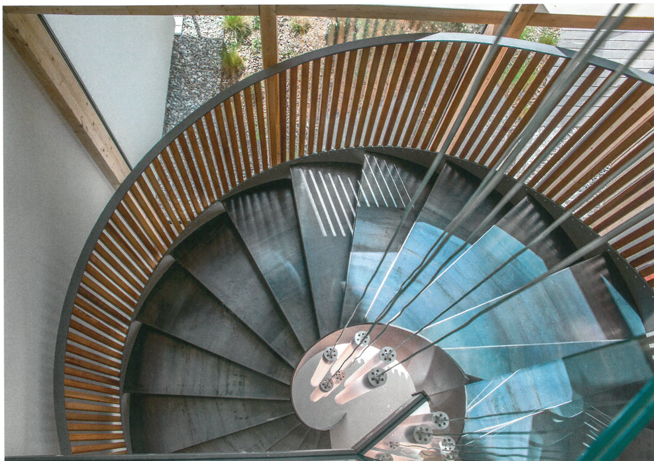
L'escalier en acier brut non traité est bien mis en valeur par un luminaire italien.
